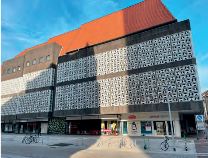
Gegenüber der hannöverschen Altstadt: Das ehemalige Kaufhaus mit der markanten Fassade steht schon lange leer. Foto: Anette Schröder
