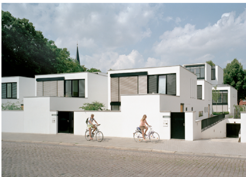
Trägt die Handschrift von ksw: Die Wohnanlage »Großer Garten« in Hannover-Herrenhausen.
