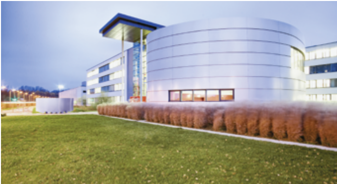
Das neue Gebäude der Fakultät für Maschinenbau entsteht gegenüber dem PZH in Garbsen. • Quelle: Dorota Sliwonik
