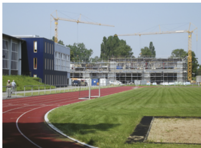
Der neue Multisportkomplex am Sportcampus wächst in die Höhe. Die Übergabe ist für das Frühjahr 2013 geplant.
