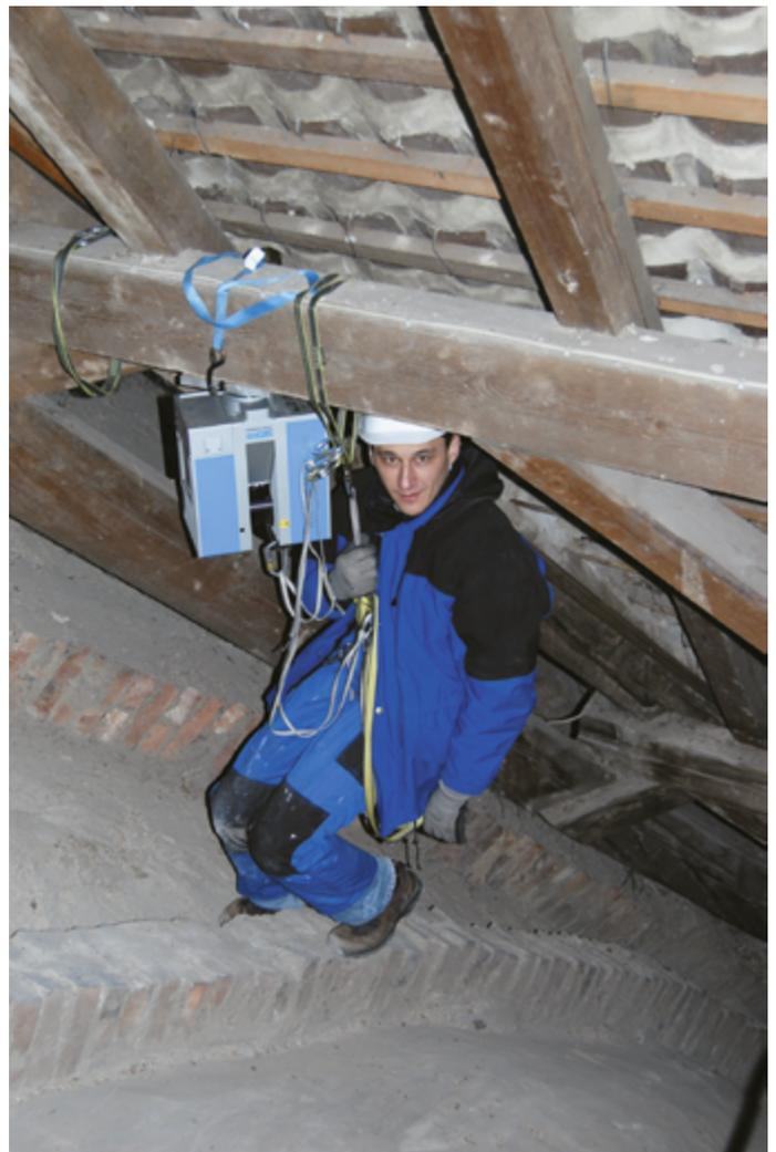
Angeseilt werden Laserscanner installiert. • Foto: Geodätisches Institut
