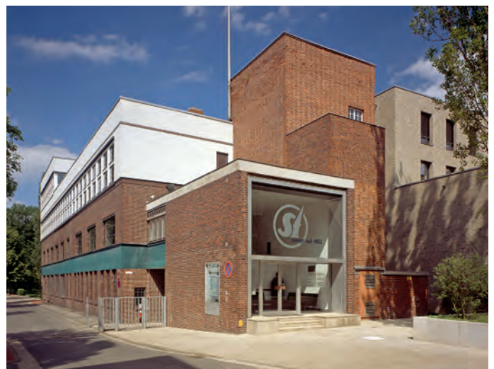
Der Eingang vom Stichweh-Leinepark, in den 1920er Jahren von Walther Wickop umgebaut. Fotograf: Jürgen Voss/Architekturfotografie
