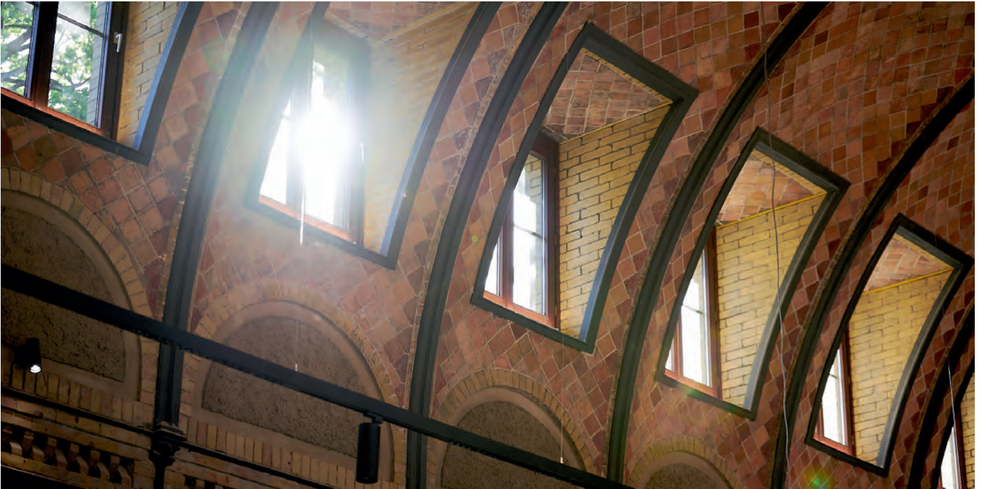
Neu saniert: die gewölbten Decken und ihre Konstruktion. Foto: Sören Pinsdorf/LUH
